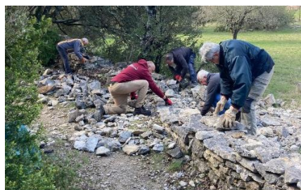
Remonter les murets en pierre sèche
