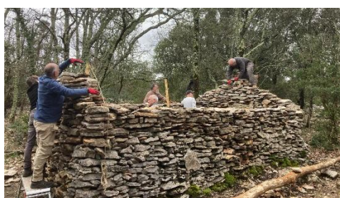
Reprendre murs et murs pignons
