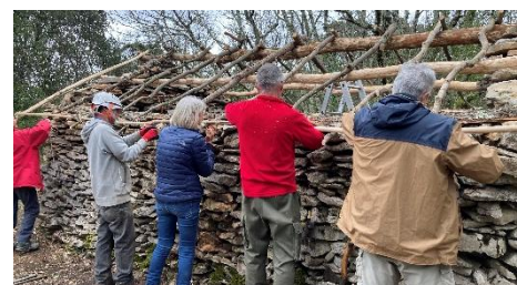
Accrocher les liteaux (en bambou) aux chevrons
